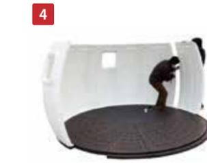
壁面下段パネルを全て連結し、下段パネルと床パネルをボルトを使って固定します。
